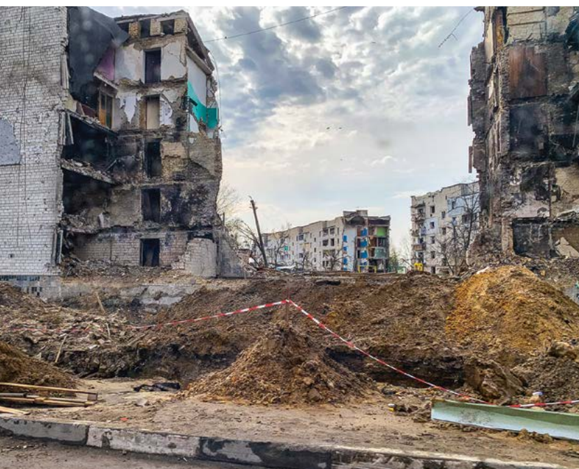
▲ Borodyanka bei Kiew: Zerstörte, beschädigte und ausgebrannte Wohngebäude.
